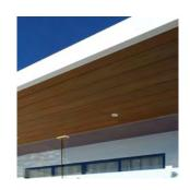
20. TIMBER SOFFIT LINING
